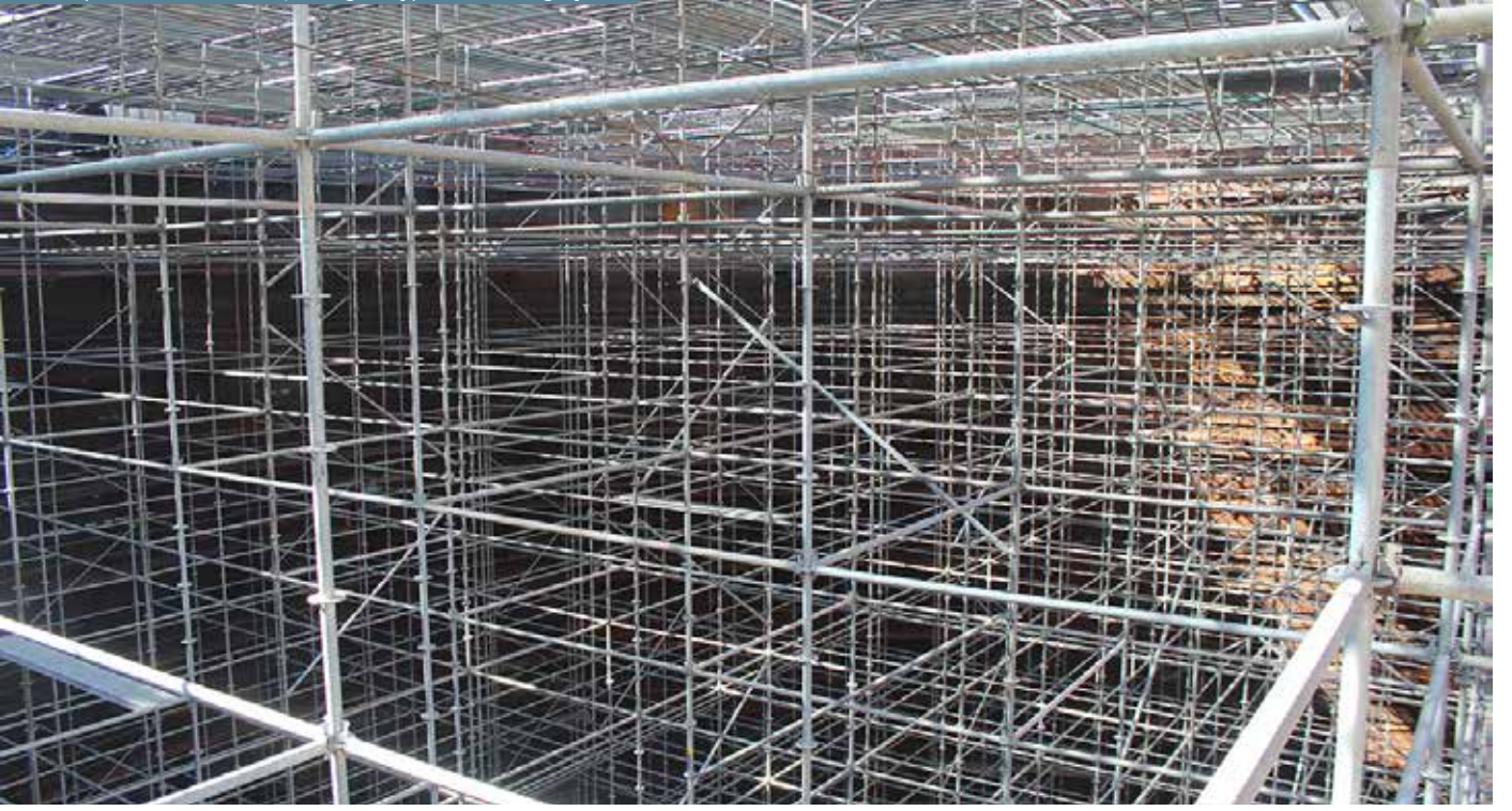
PROJE ADI : ENDÜSTRİYEL TESİS FLANŞLI İSKELE SİSTEMİ / Flanged Type Scaffolding System
