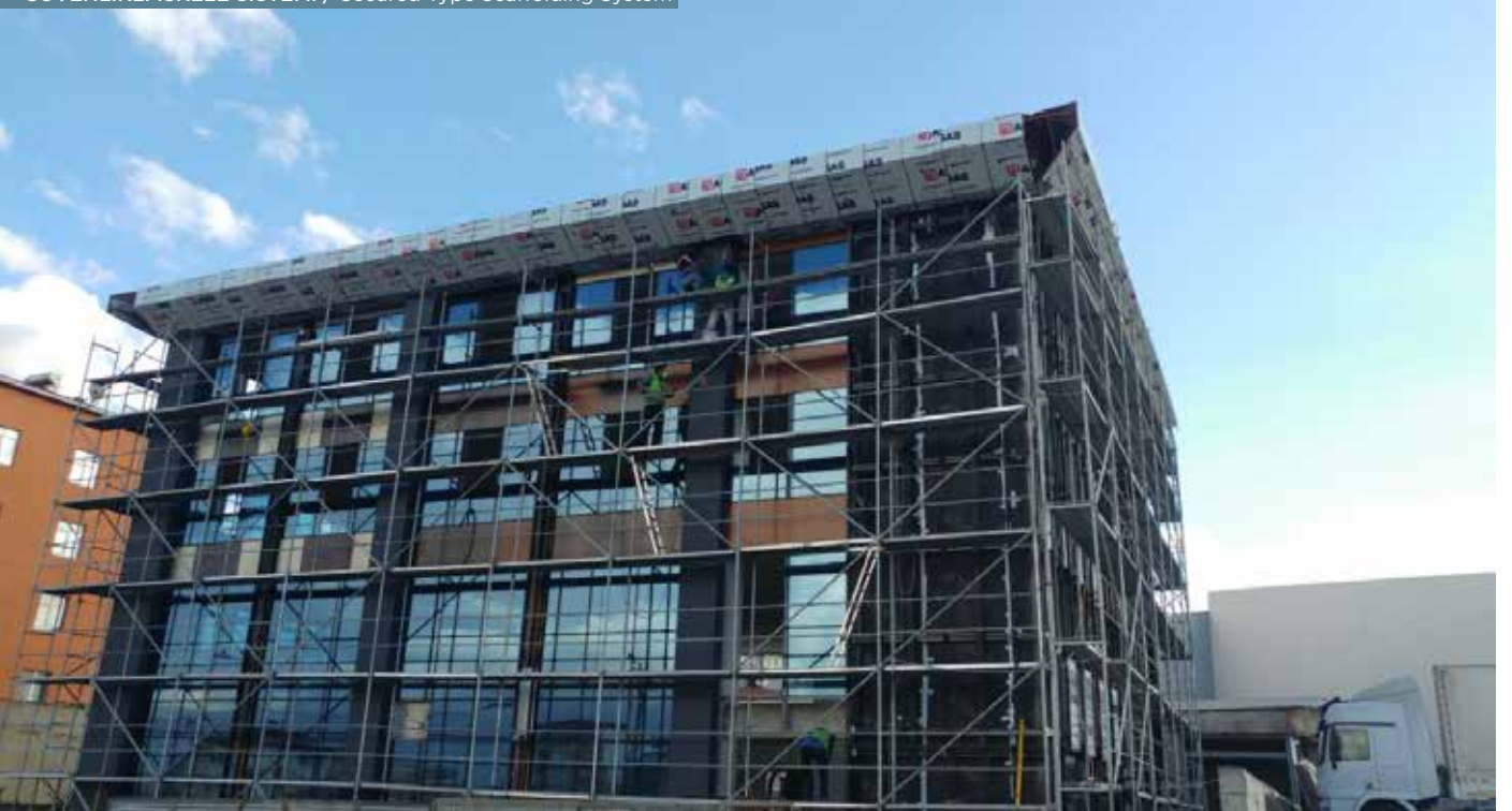
PROJE ADI : KONUT FERHATPAŞA GÜVENLİKLİ İSKELE SİSTEMİ / Secured Type Scaffolding System
