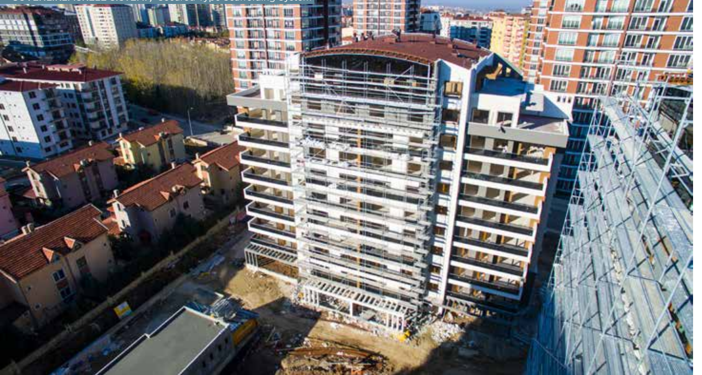
PROJE ADI : KONUT ÇORLU GÜVENLİKLİ İSKELE SİSTEMİ / Secured Type Scaffolding System
