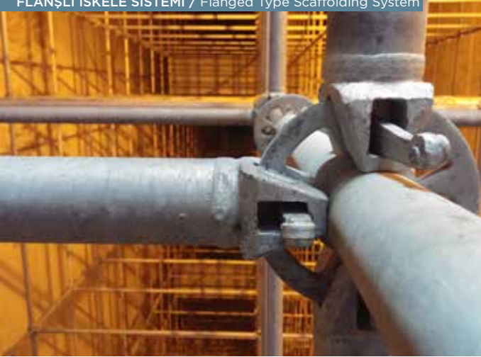
PROJE ADI : OSMANGAZİ KÖPRÜSÜ FLANŞLI İSKELE SİSTEMİ / Flanged Type Scaffolding System
