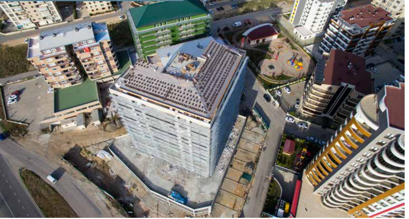
PROJE ADI : KONUT BURSA GÜVENLİKLİ İSKELE SİSTEMİ / Secured Type Scaffolding System
