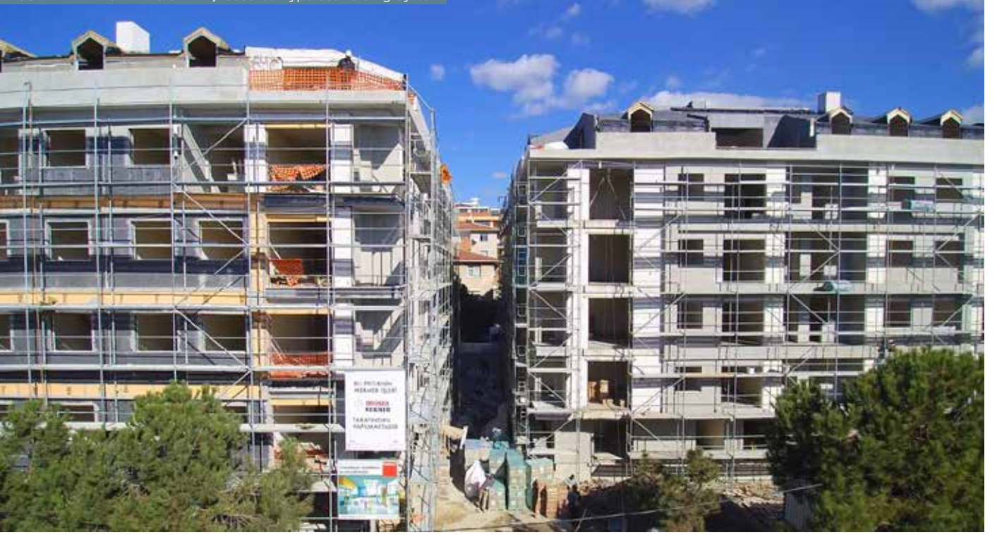
PROJE ADI : KONUT KÜÇÜKYALI GÜVENLİKLİ İSKELE SİSTEMİ / Secured Type Scaffolding System
